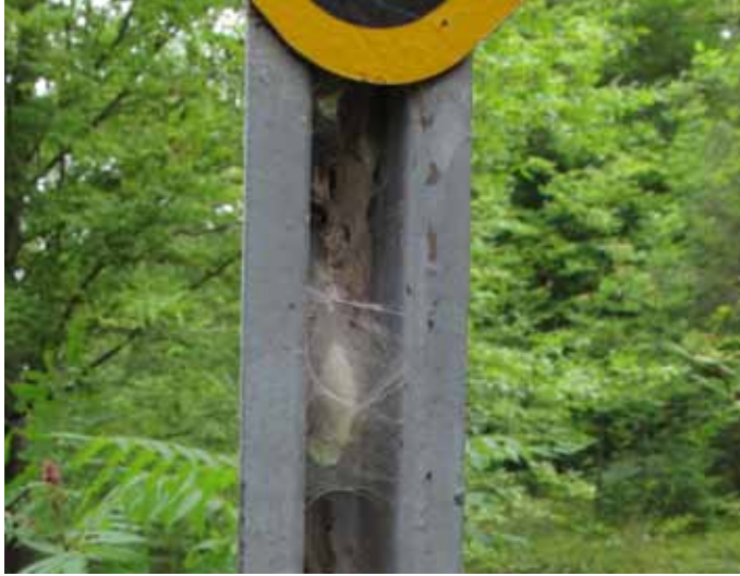
Figure 4: Cocon de la livrée des forêts, dans le creux du poteau d'un panneau de signalisation (photo : Patrick Hodge, ministère des Richesses naturelles)
